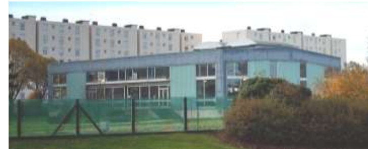
Piscine des Bords de Loire – Source : Citadia Conseil
